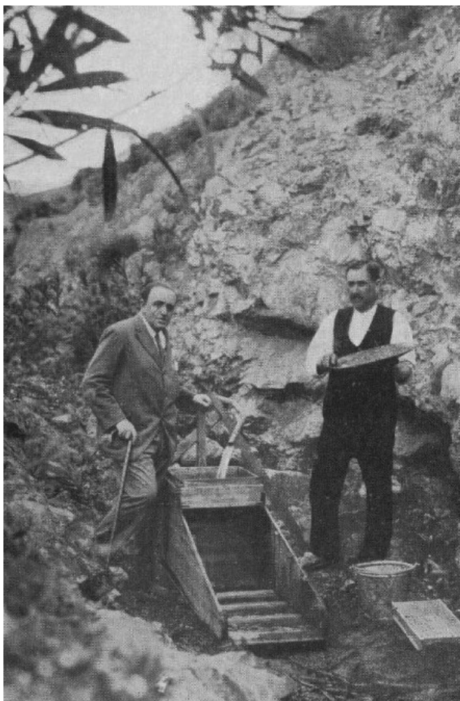
Figura 6. Rocker para el tratamiento de las arenas platiníferas, construido en la Fábrica Orueta de Gijón (tomado de Rubio, 1927). Figure 6. Rocker for the treatment of platinum-rich sands, built in Orueta's Factory in Gijón (Rubio, 1927).
